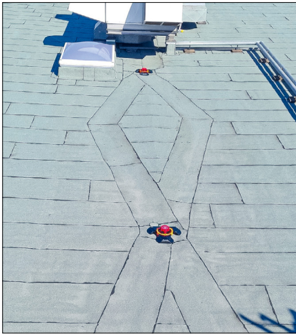
Bild 3: Der Abfluss des Regenwassers erfolgt über Gullys und eine Linienentwässerung in der Mitte der Dachflächen.
