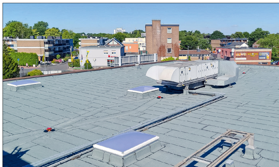
Bild 2: Insgesamt sechs ROOFGUARDS mit FLECK connect wurden auf dem Flachdach mit einer Größe von 2.400 m² verbaut. Auf dem Bild sind insgesamt drei Stück zu sehen.
