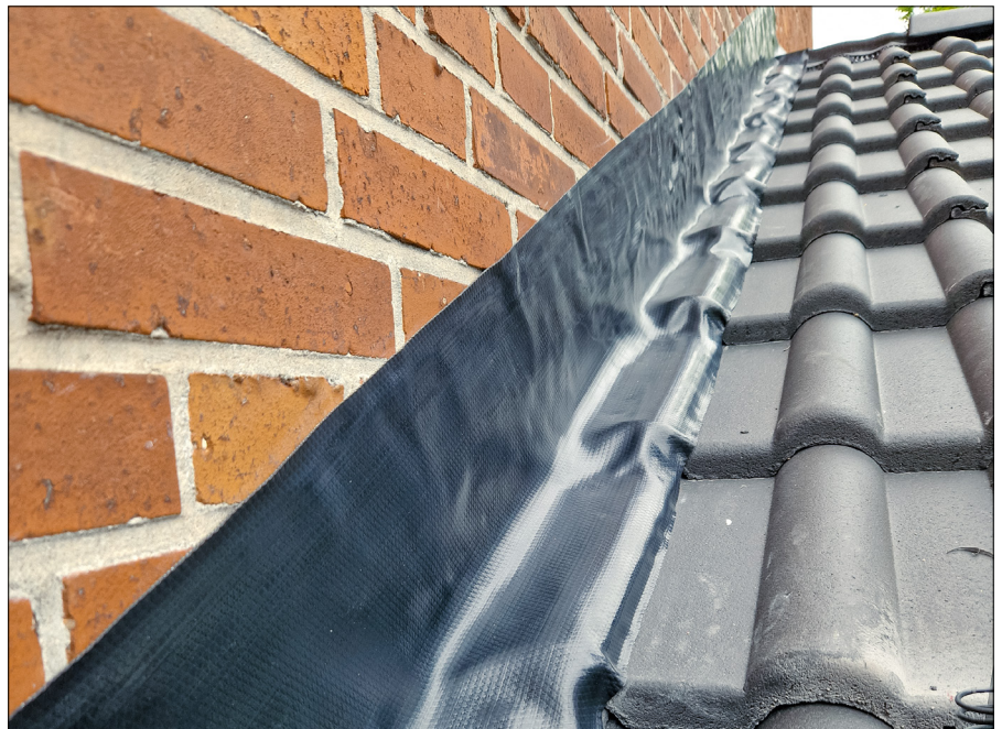
Bild 3: Es lassen sich sogar alle Details der Dachpfannen formschlüssig herausbilden.
