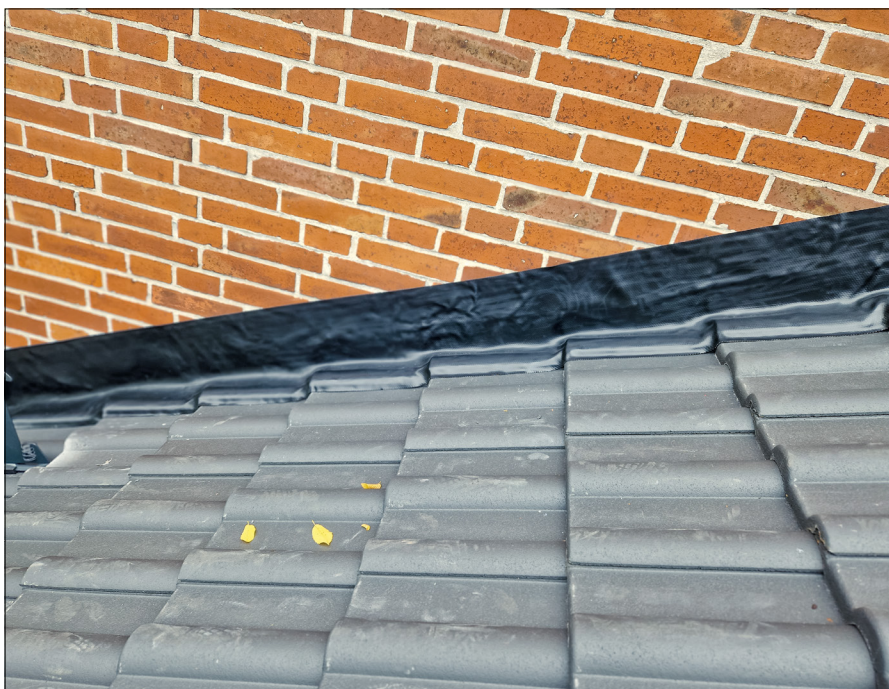
Bild 4: Das Ergebnis kann sich sehen lassen: Der Dach-Wand-Anschluss wurde nahtlos und wetterfest ausgeführt.
