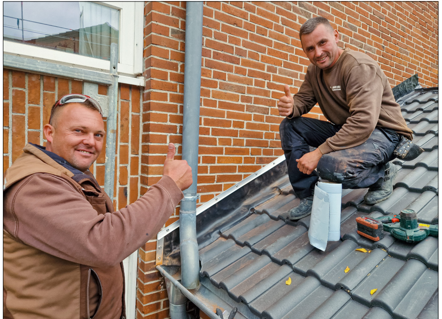
Bild 5: Zum Schluss wurde noch eine Anschlussleiste angebracht, damit ablaufendes Wasser von der Fasadefläche fachgerecht abgeleitet wird. Wladimir Kleer (l.) und Sylvester Kawka (r.) zeigen sich begeistert von ECO FORM EASY.
