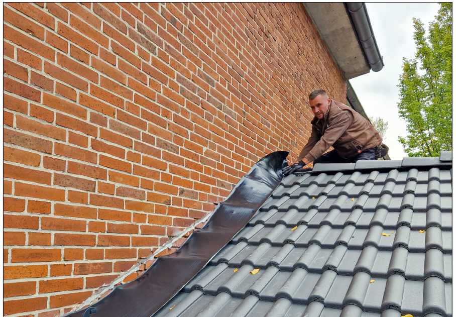
Bild 1: An der Schule wurde ein Dach-Wand-Anschluss zu einem Nebengebäude erneuert. Die ausführende Firma war ISOHAUS Bedachungen GmbH & Co. KG aus Hamburg.
