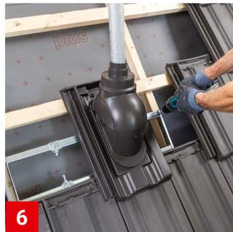
**6** Antennenhalterung gem. Einbauanleitung montieren.
