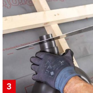
**3** Antennenstab spannungsfrei einbauen. Öffnung der Antennendurchführung ggf. durch Einkürzen mit einer Säge anpassen.
