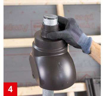
**4** Antennendurchführung über den Antennenstab schieben und Einbauichtung des Oberteils gem. vorhandener Dachneigung wählen<sup>1</sup>.
