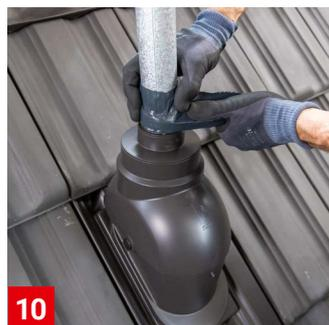
**10** Spalt zwischen der Antennendurchführung und dem Antennenstab mit geeigneten Dichtungsmitteln fachgerecht abdichten.
