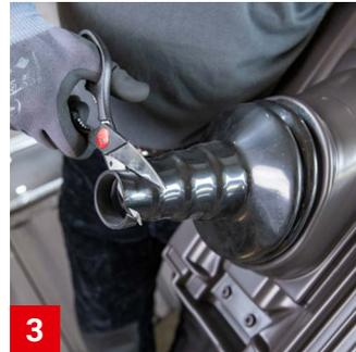
**3** Antennenstab spannungsfrei einbauen. Öffnung der Antennendurchführung ggf. durch Einkürzen mit einer Schere anpassen.
