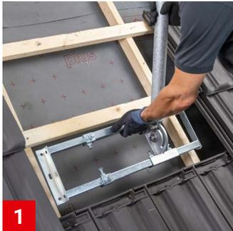
**1** Antennenhalterung gem. Montageanleitung positionieren – noch nicht befestigen.
