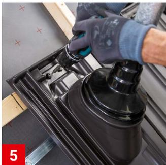
**5** Durchgangspfanne an der Dachlatte mithilfe von Spenglerschrauben befestigen, die an den Befestigungspunkten gesetzt werden.
