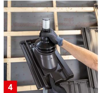
**4** Antennendurchgangspfanne über den Antennenstab schieben.
