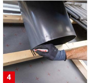
Anschlussstutzen des Lüfters an der gewünschten Einbauposition auf die Traglattung setzen und rechts und links des Anschlussstutzens kennzeichnen.
