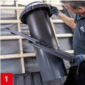
Der hier gezeigte Einbau eines Wrasenlüfters DN 300 gleicht dem Einbau aller weiteren Größen. Hinweis: Ab Größe DN 400 wird der Einbau zu zweit empfohlen.
