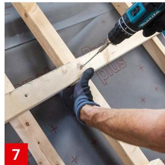
Empfehlung: zusätzliche Konterlatte an der Schnittkante der Traglatte anbringen, um für eine ausreichende Lastabtragung zu sorgen.
