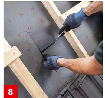
Unterspannbahn kreisförmig an der markierten Stelle einschneiden. Die Schnitte müssen so lang sein, dass der Anschlussstutzen des Wrasenlüfters hindurchpasst.
