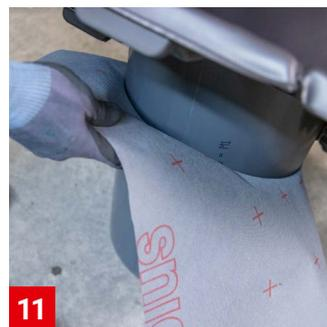
Die so entstandene Manschette bis zur späteren Unterspannbahnebene über das Unterrohr des Lüfters ziehen.
