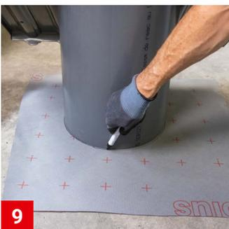
Zum Schutz vor eindringendem Wasser wird die Anfertigung einer maßgeschneiderten Unterspannbahn-Dichtmanschette empfohlen.
