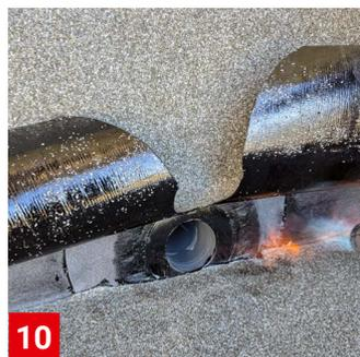
**10** Oberlage um die Ablauföffnung herum sorgfältig und dicht abschließend aufschweißen.
