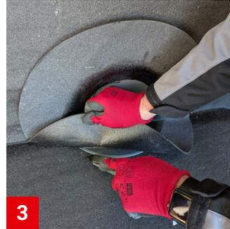
**3** Markieren und Ausschneiden der PVC-Flanschtellerkontur aus der ersten Bitumenlage.
