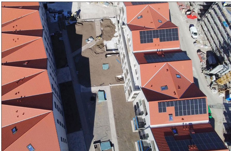
Auf mehreren Gebäuden der „7 Höfe“ sorgen moderne Photovoltaikanlagen für umweltfreundliche Energiegewinnung.
