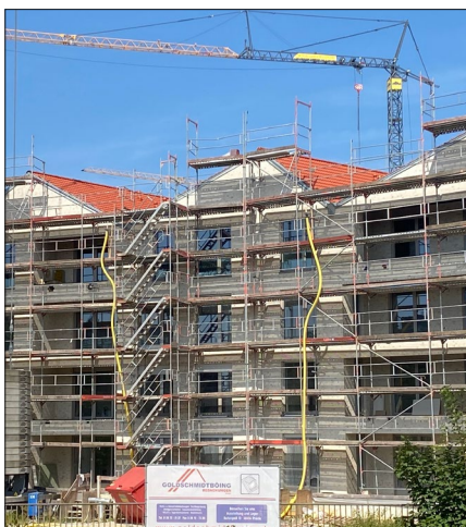
Die Bauarbeiten im Quartier „7 Höfe“ schreiten sichtbar voran und die Dachformen sind bereits erkennbar – umgesetzt durch die Goldschmidtböing Bedachungen GmbH.
