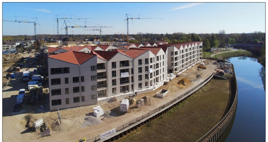
Das neue Quartier „7 Höfe“ verbindet modernes Wohnen harmonisch mit der naturnahen Lage an der Bocholter Aa.
