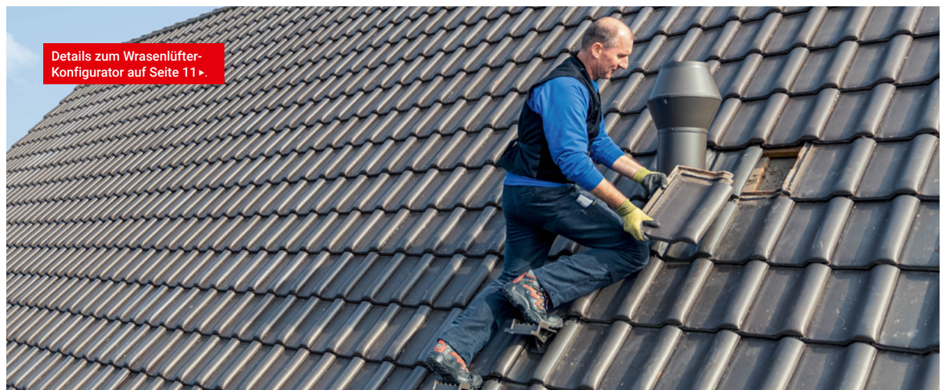
Einbau eines Wrasenlüfters mit Flairkopf – eine sichere Sache mit dem Sicherheitstritt von FLECK.
